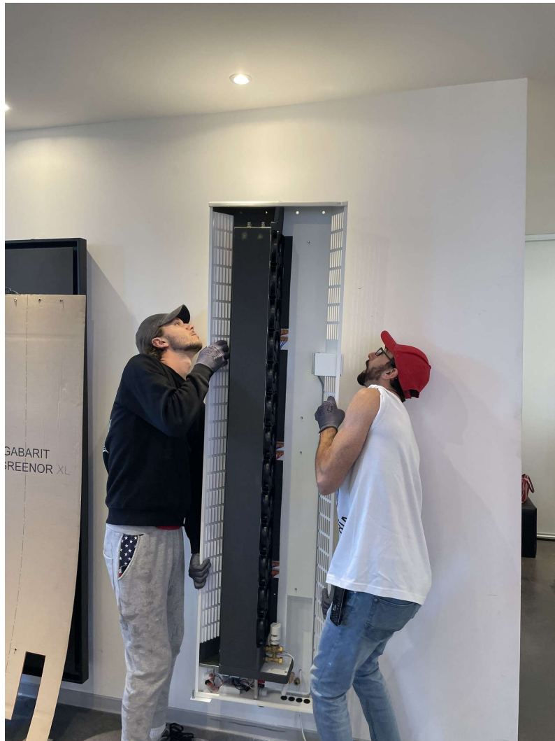
Transport und Montage des Geräts durch zwei Monteure
