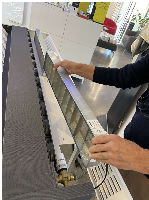
Entnahme des GREENOR XL Filters zur Reinigung
