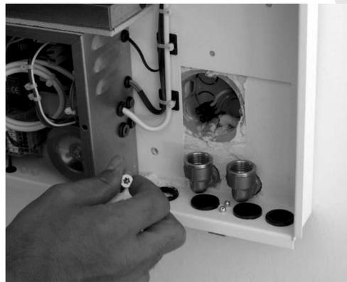
**3.28** - Fixation de la vis du bas pour bien le châssis au mur
