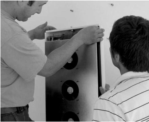
**3.25** - Fixation du châssis technique
