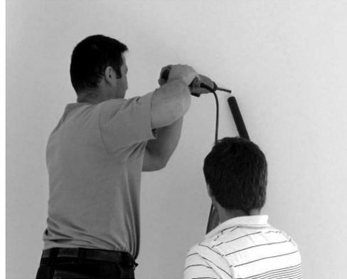
**3.12** - Percer les trous pour adapter les chevilles de fixation
