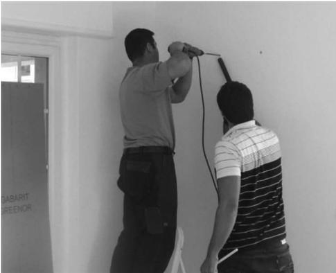
**3.13** - Percer entre 2 et 4 trous pour la fixation haute du Greenor selon le mur et la qualité des chevilles utilisée
