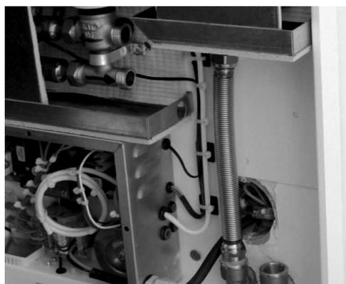
**3.32** - Branchement hydraulique du chassis grace aux flexibles de connections fournis-bis
