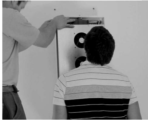
**3.26** - Fixation du Châssis sur le mur- prévoir 2 personnes !
