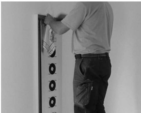
**6.39** - Important -Renouveler l'opération de purge autant que nécessaire-utiliser également un chiffon pour éviter les éclaboussures
