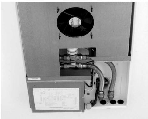
**3.35** - Chassis technique raccordé hydrauliquement et électriquement- OK pour passer à la suite
